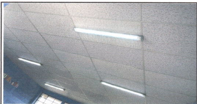
Foto 5: Sustitución de cielo Falso de duroport por cielo falso de tabla yeso
