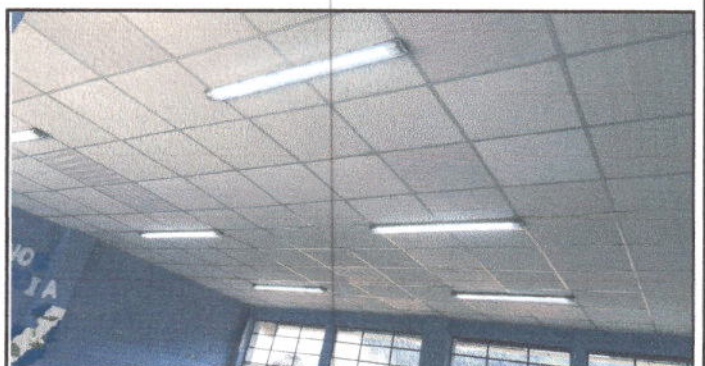
Foto 6: Sustitución de cielo Falso por cielo Falso de tabla Yeso
