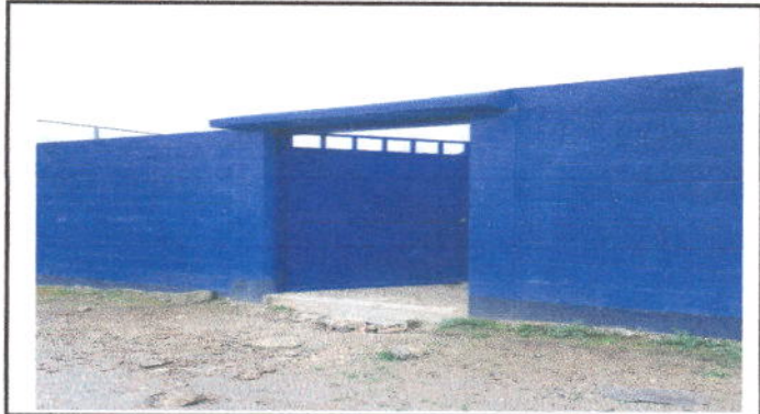
Foto 1: Sustitución de puerta de metal por puerta de metal principal
