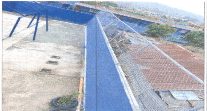
Foto 4: Sustitución de muro de teja por muro de block
