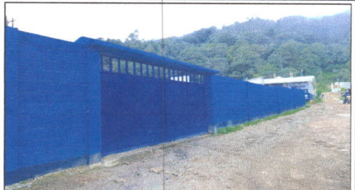
Foto 2: Sustitución de porton de madera y teja por porton de metal principal
